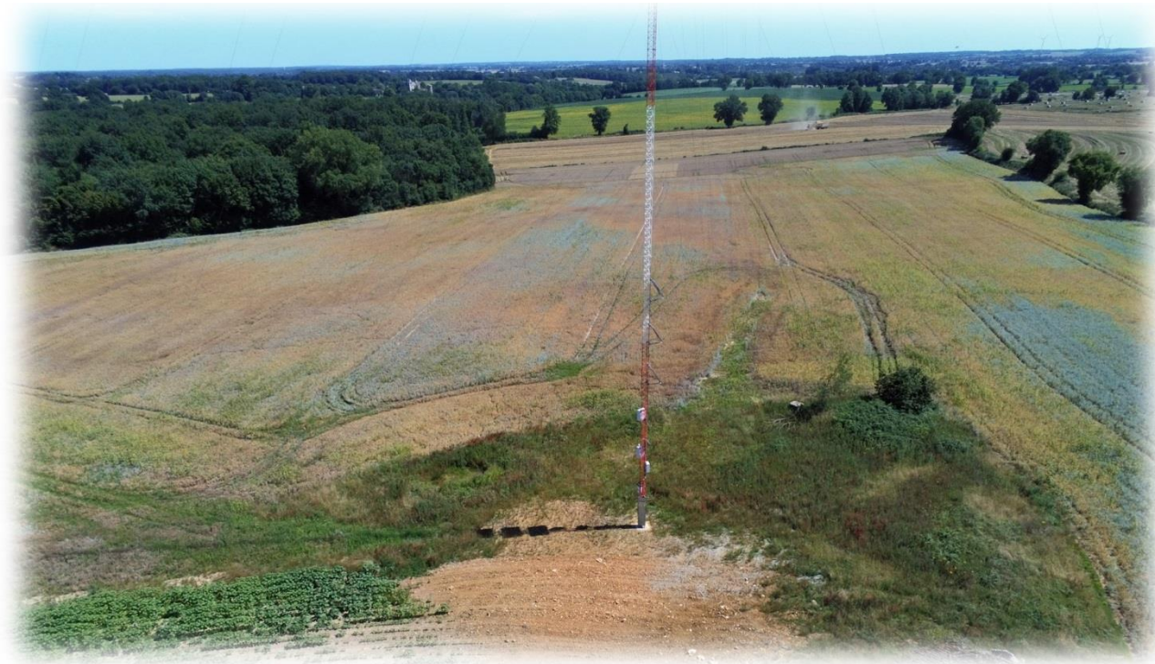
Photo 140 : vue aérienne par drone à hauteur de l'emplacement de l'éolienne E2 (07/07/2020)
